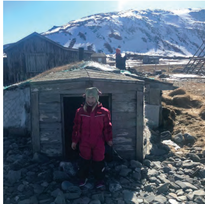
Ishuset er dekket med torv på sidene.
