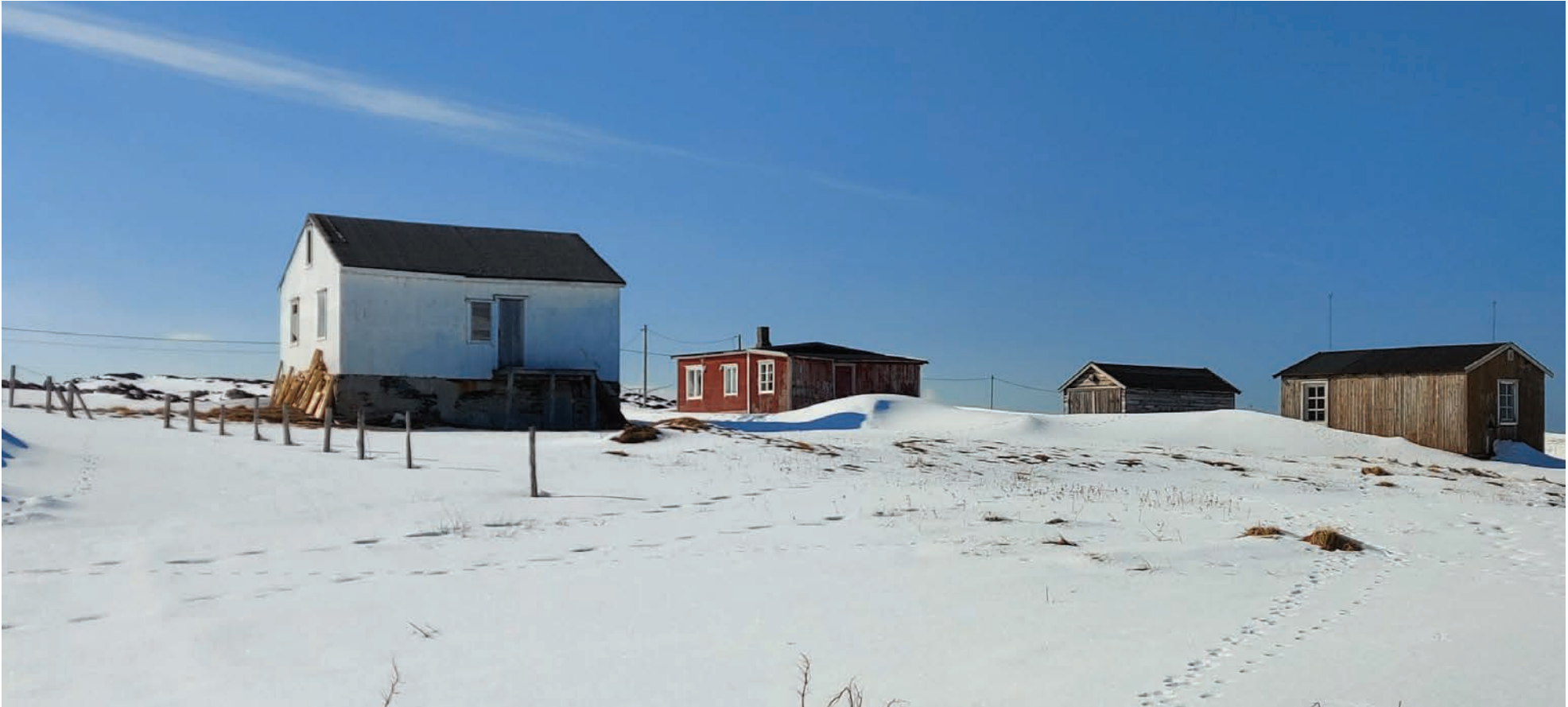
Kilbotnstøa. Det røde huset midt i bildet var bebodd helt frem til 1968.
