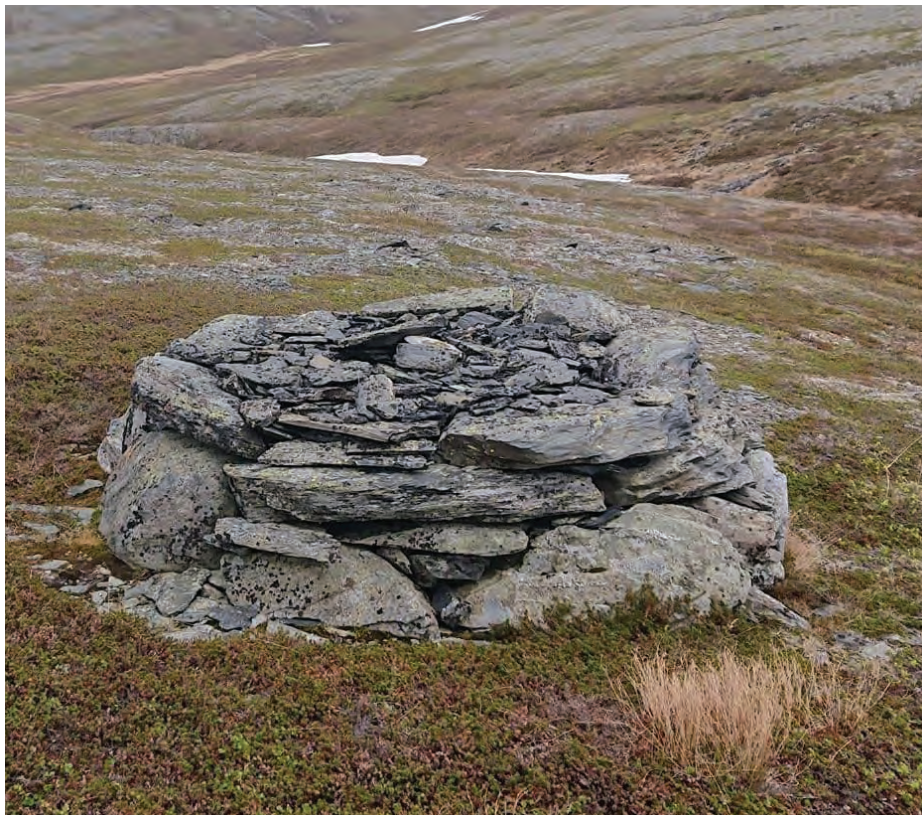
Steinfundament til en telegrafstolpe.
