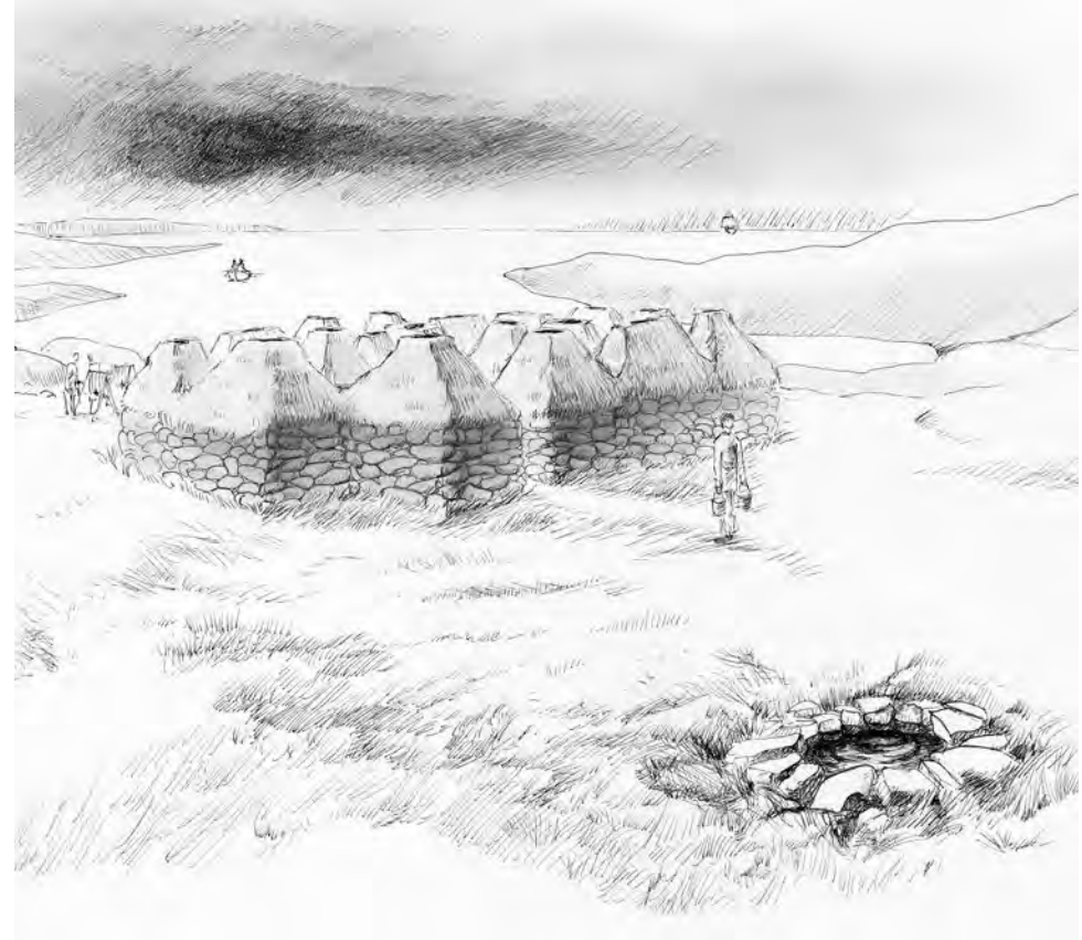
Illustrasjonstegning av hvordan mangeromshusene i Kongshavn kan ha sett ut. Den godt bevarte brønnen i forkant. Illustrasjon: Kristina Steen
