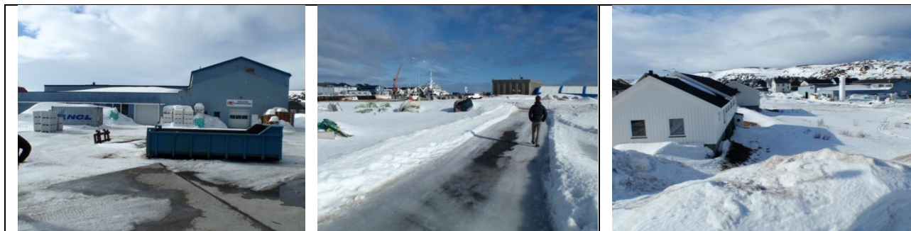
Foto som viser eksisterende bebyggelse innenfor planområdet. Til venstre; eksisterende fabrikkbygning, i midten; Hydraulikk Finnmark, til høyre; eksisterende bebyggelse langs Fv. 890.
