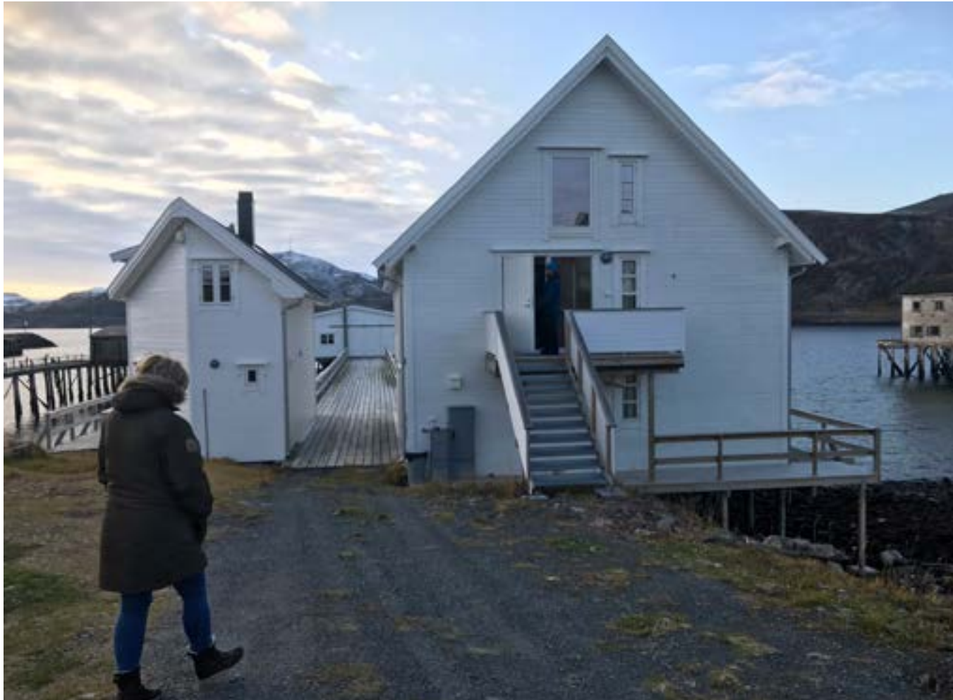
Lovisenborg er restaurert til overnattingsted for turister. Den tidligere bestyrerboligen til venstre og pakkhuset til høyre.
