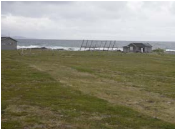
Russehavna. Hytta til høyre er den som også har blitt brukt som naust. Rett til høyre for den det torvdekte ishuset. Seihesjen i midten av bildet. Foto: Berlevåg Havnemuseum
