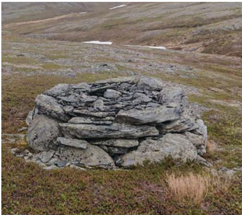
Steinfundament til en telegrafstolpe.
