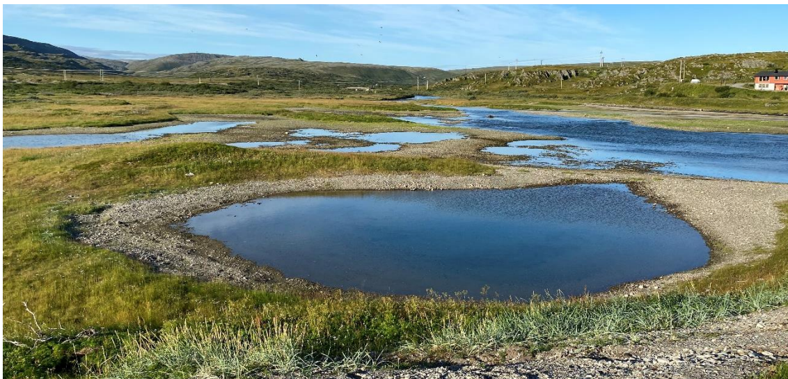
Figur 4-11. Brakkvannsonen oppstrøms fylkesveien ved fjære sjø. Bildet er tatt mot sør. Jernbanebrua krysser Storelva i bakgrunnen midt på bildet. Foto: Sweco Norge.
