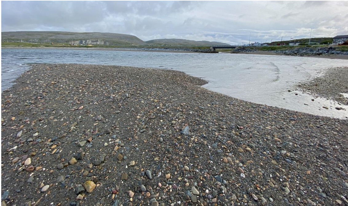
Figur 4-7. Gruntvannsområder innerst i Revnesbukta på fjære sjø. Brua over utløpet av Storelva i bakgrunnen til høyre. Foto: Sweco Norge.
