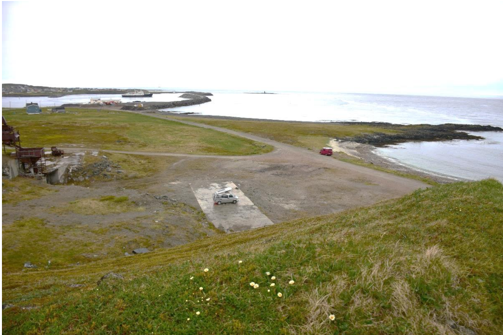
Figur 5-11. Området mellom Storelvberget og Revnesbukta. Bildet er tatt fra Storelvberget mot Revnesbukta. Steinbrudd til venstre. Foto: Sweco Norge.
