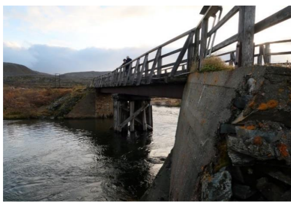
Figur 20 - Jernbanebrua. Foto: Bjarne Mjelde
