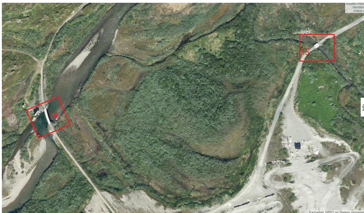
Figur 19 - Jernbanebrua og Finabrua. Foto: Norgeskart.no
